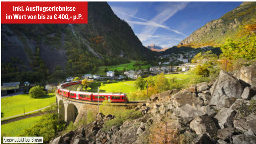
Kreisviadukt bei Brusio
